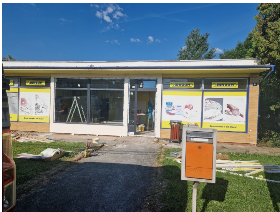
Probíhající rekonstrukce od 17.6.2024
